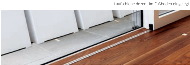
Laufschiene dezent im Fußboden eingelegt.
